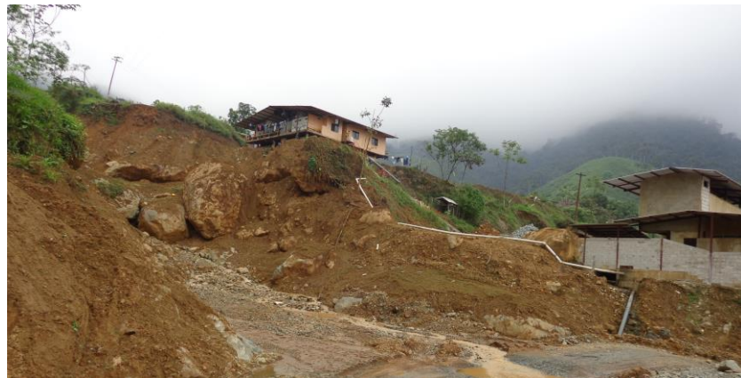
FOTOGRAFÍA 2.1.97 CANTÓN CAMILO PONCE ENRIQUEZ: Viviendas vulnerables sector Pueblo Nuevo.
