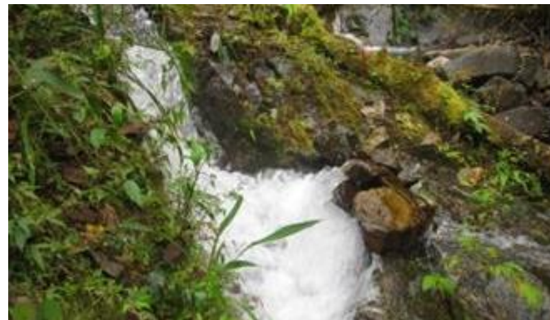
FOTOGRAFÍA 2.1.28 CANTÓN CAMILO PONCE ENRIQUEZ: Toma lateral rústica para canal de riego. Sector San Juan de Naranjillas Cuenca del Río Gala.
