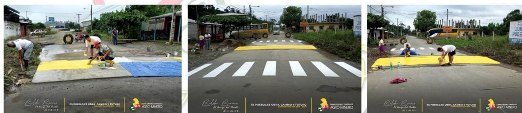
Construcción y señalización de reductor de velocidades en barrio 20 de octubre-Shumiral.
